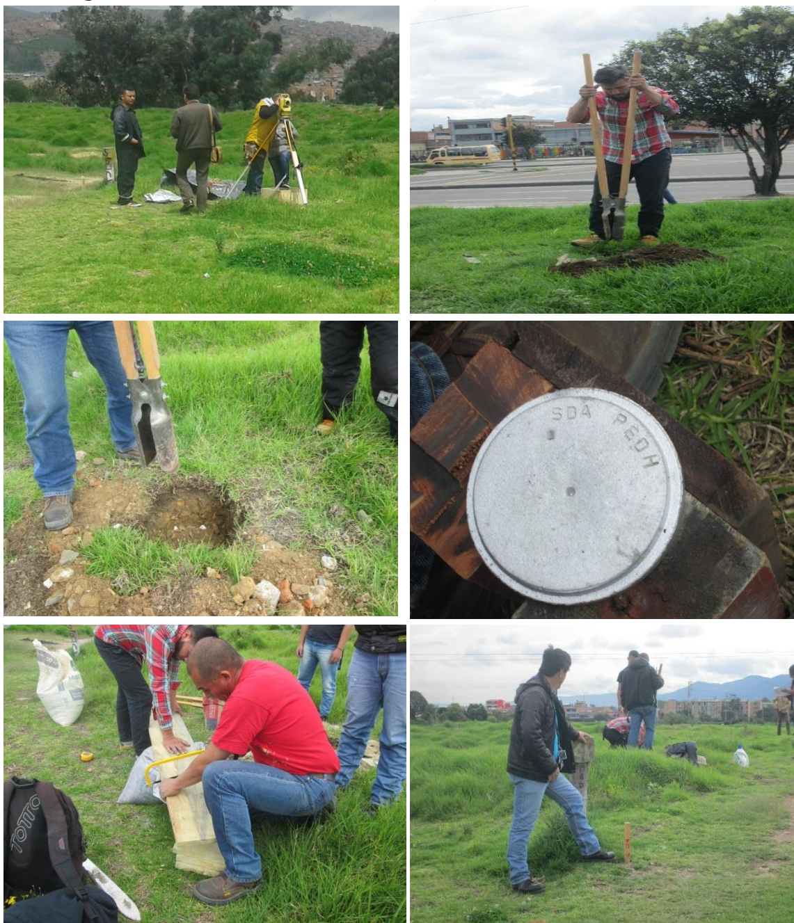
Fotografía 2 Evidencia del levantamiento topográfico y Estacas instaladas en el replanteo.
